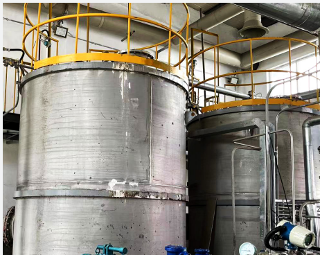
泥浆砂浆泵送
